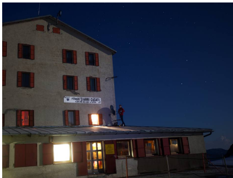
Lavori di installazione presso il rif. Casati (foto Necchi)
