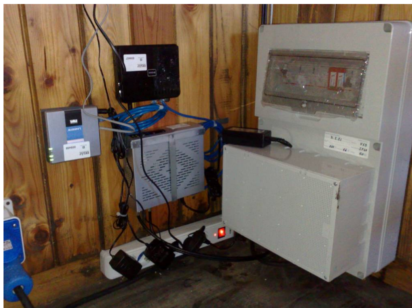
I componenti - modem, router, apparati di protezione sovratensioni e adattatore VoIP (foto Grimaldi)
